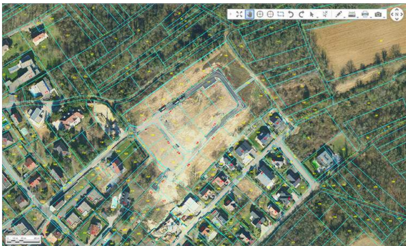
Photo aérienne de 2022 montrant l'avancée des travaux sur la zone 1AUa
