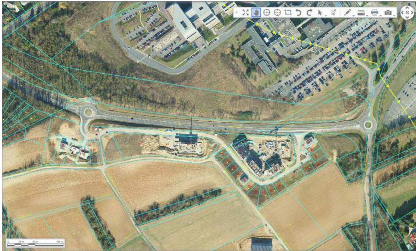
Photo aérienne de 2022 montrant l'avancée des travaux sur la zone 1AUC
