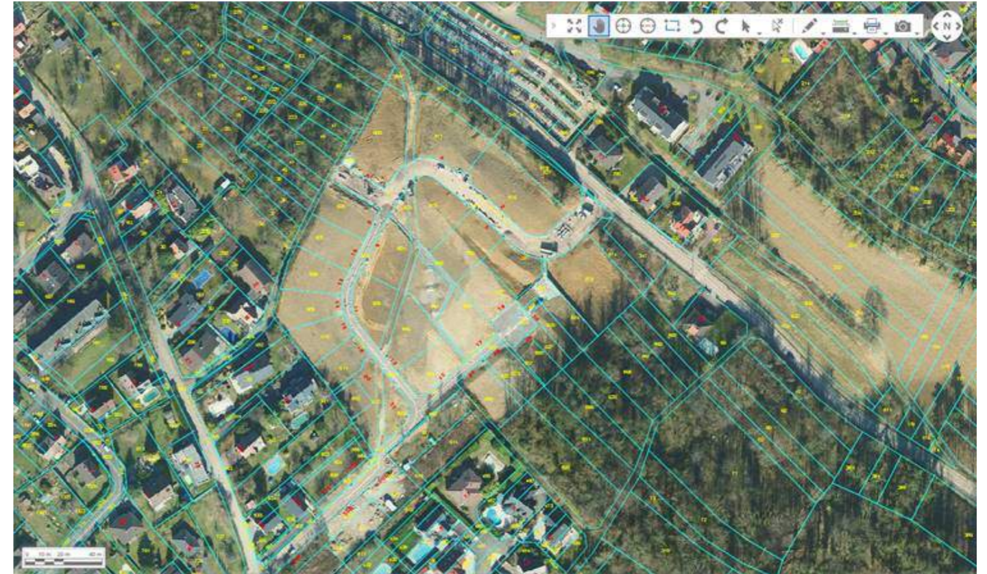
Photo aérienne de 2022 montrant l'avancée des travaux sur la zone 1AUb
